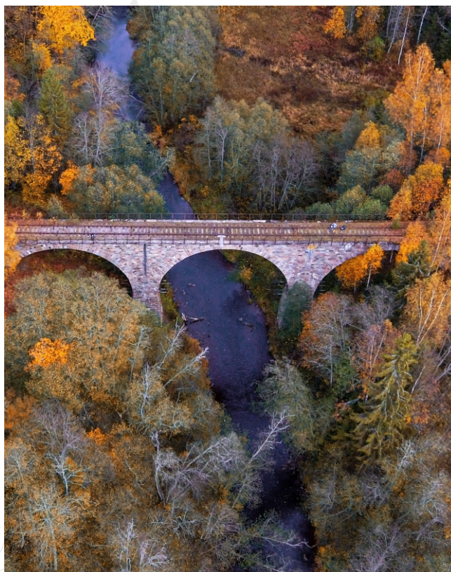
КАМЕННЫЙ МОСТ ЧЕРЕЗ Р. ЯРЫНЬЯ, КРЕСТЕЦКИЙ РАЙОН
